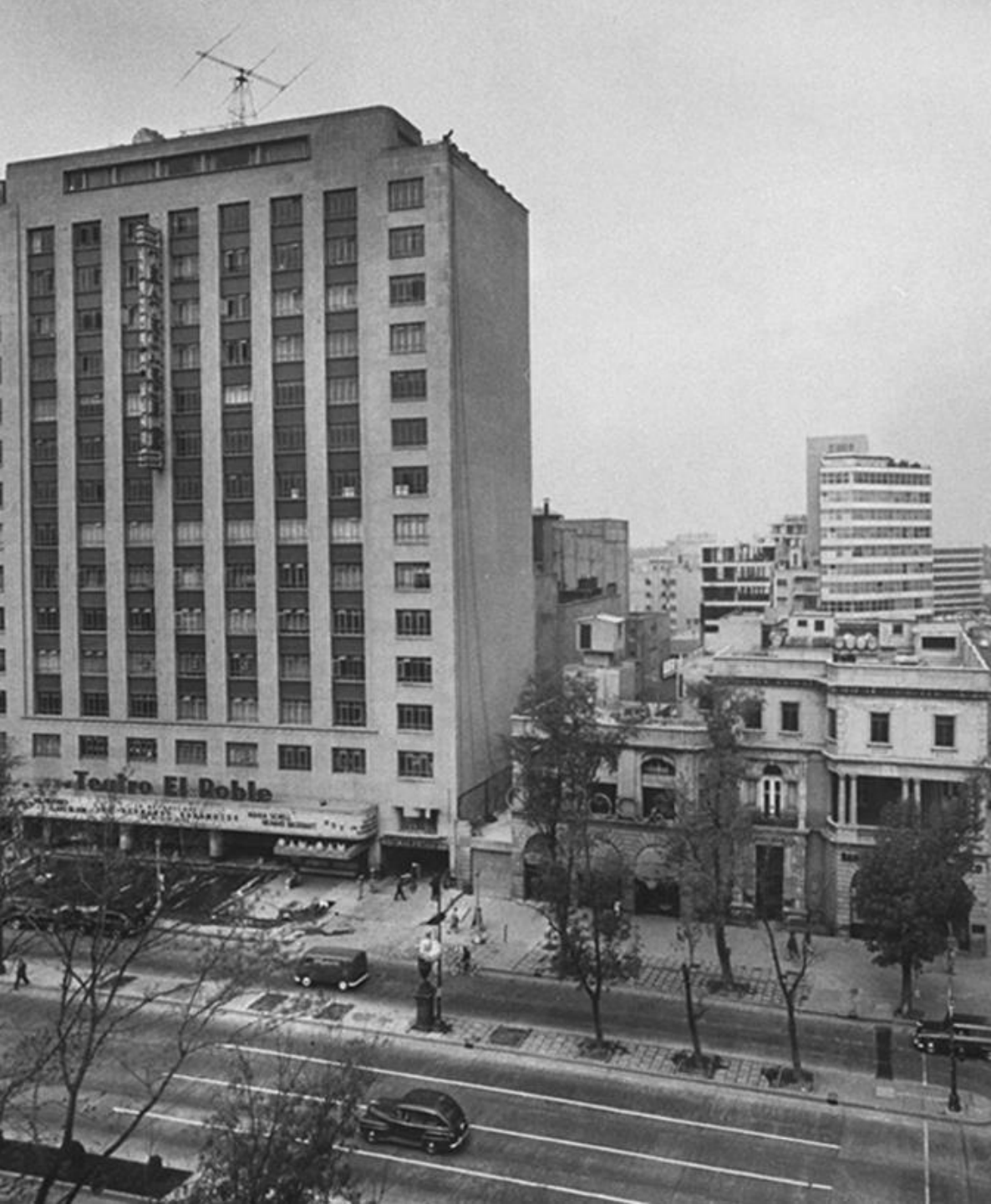
Edificio y Cine El Roble
