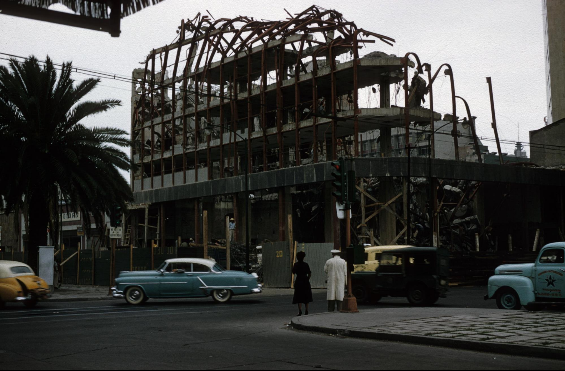
Edificio en construcción en Ignacio Ramírez y Artes (Antonio Caso)
