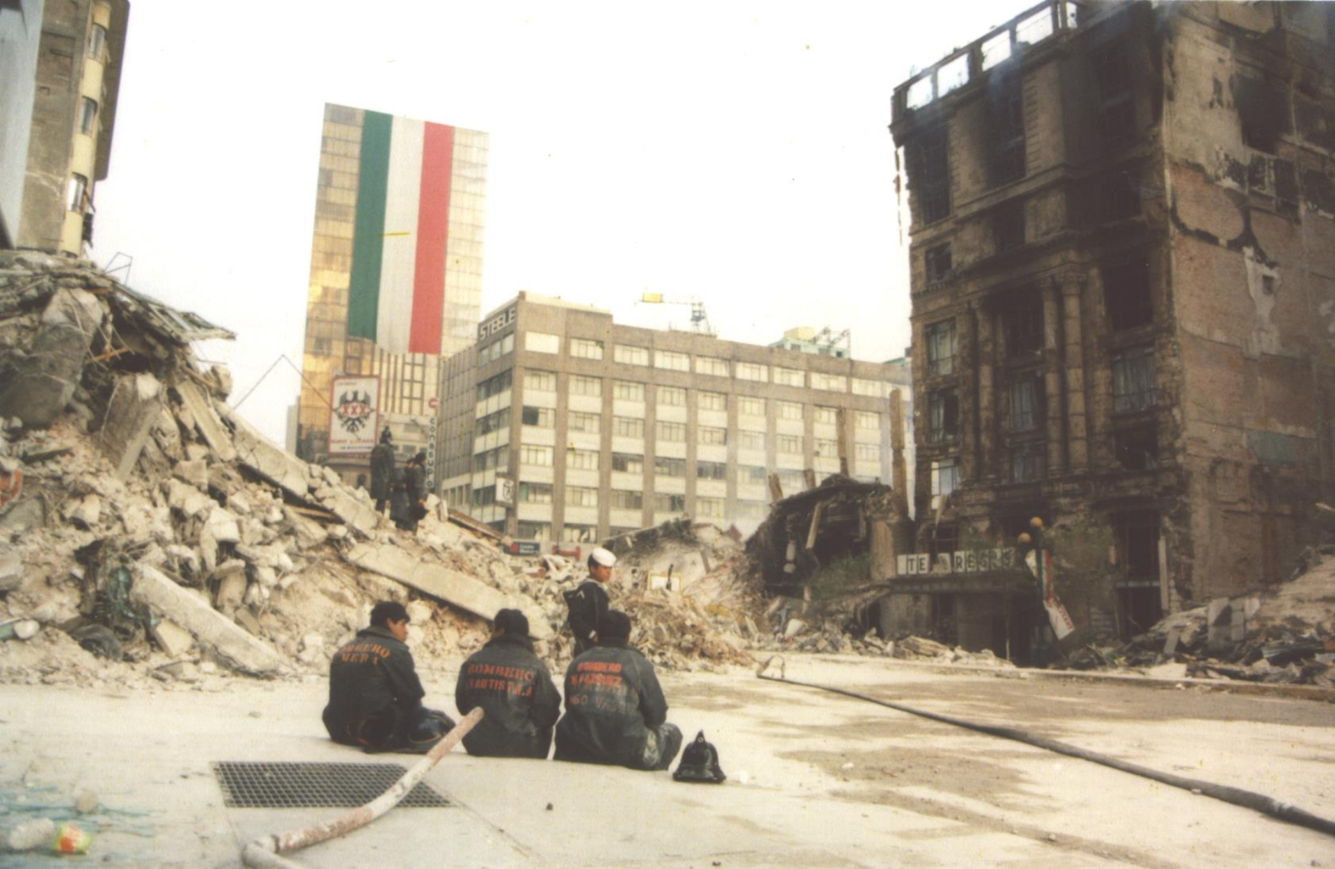
Ruinas en avenida Juárez
