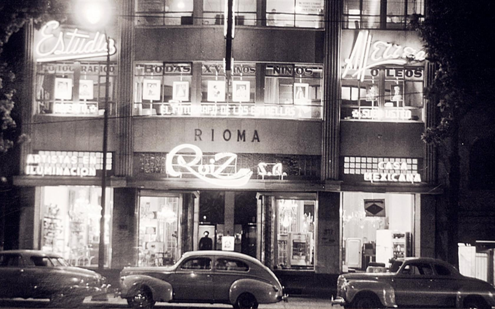
Estado original del edificio Rioma, propiedad de “Cantinflas”
