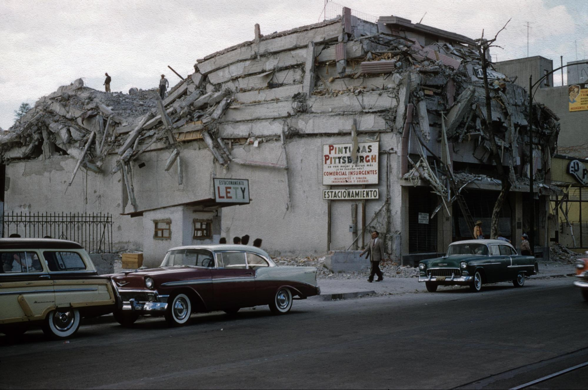
Así quedó el edificio Rioma en Insurgentes y Michoacán
