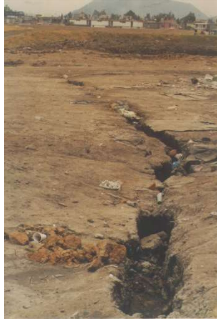
Grietas en la zona de transición de la Calz. I. Zaragoza hacia la Sierra de Santa Catarina
