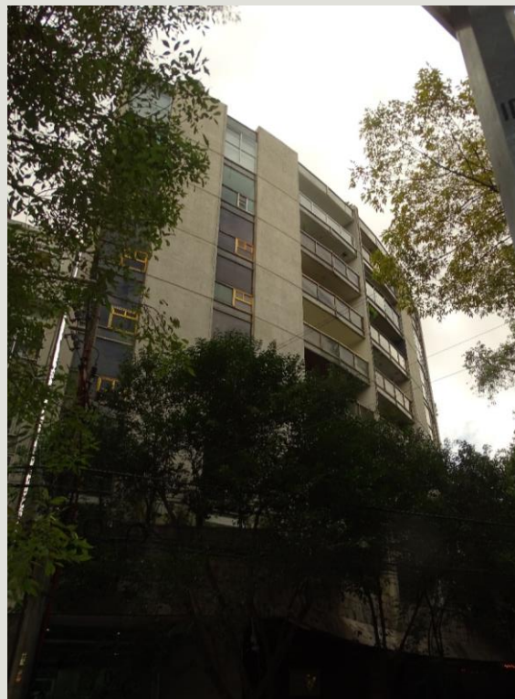
Edificio Departamentos 10 Niveles Columnas, Trabes, Losa Plana
