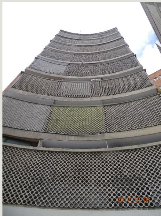
Ámsterdam e Iztaccíhuatl Col. Hipódromo Del. Cuauhtemoc CDMX
