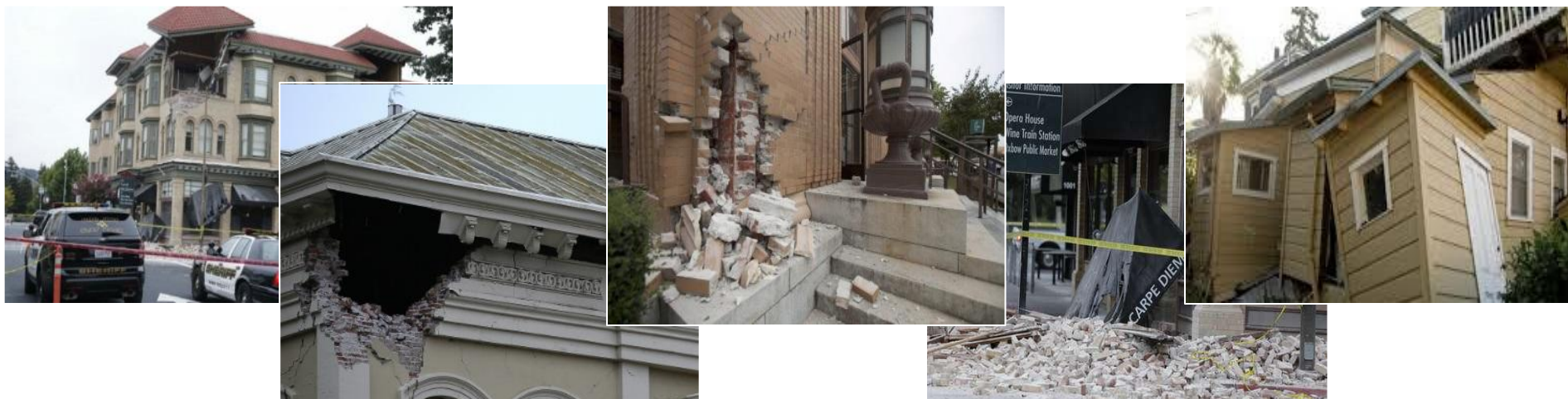
Derrumbes parciales en muros de carga y fachadas en edificios públicos en el centro del condado de Napa
