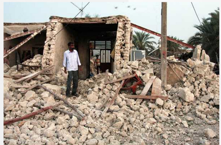
Figura 2. Viviendas dañadas en la provincia de Bushehr (Foto: Agencia AP)
