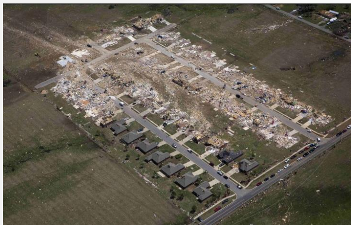
Figura 4. Vista aérea después del paso del tornado en Vilonia, Arkansas. Fuente: Carlo Allegri/Getty Images.
