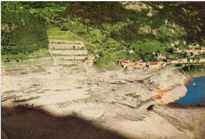
Figura 3 Pueblo Longarone antes y después del accidente
