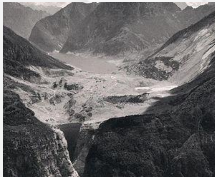
Figura 2 Vista de la presa Vajont después del deslizamiento
