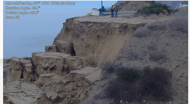
Figura 2. Derrumbe en el kilómetro 93 de la Carretera Escénica Tijuana-Ensenada (Foto: CNN México)
