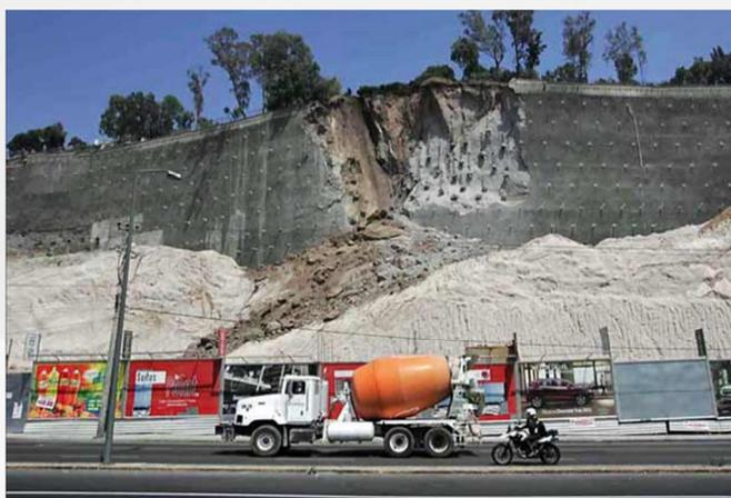
Figura 1. Imagen de movimiento de talud. (Datos: Reforma)
