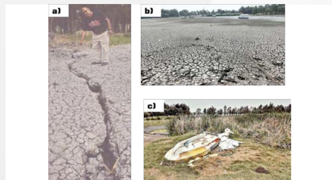
Figura 7. Aspecto de los agrietamientos longitudinales (a) del terreno y agrietamientos en arreglo poligonal debido a la posterior desecación (b) de los lodos.
