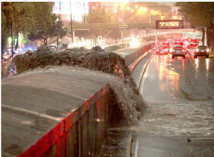
Figura 1. Uno de los lugares que más se vieron afectados fue sobre el Viaducto Río de la Piedad. Fuente: El Universal.
