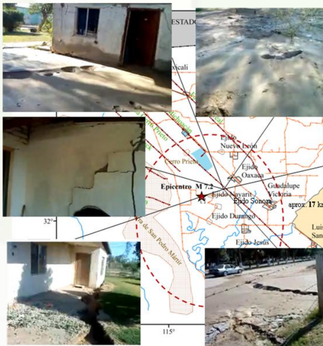
Figura 6. Algunos sitios donde se presentaron daños cercanos al epicentro (casos del Ejido Nayarit y Zacamoto).
