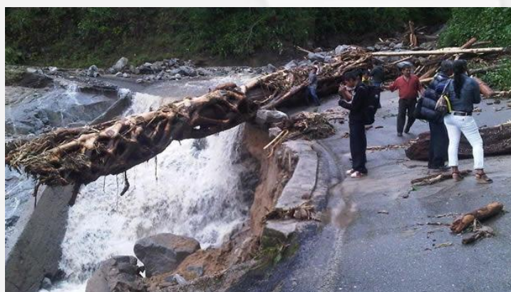
Figura 4. Varios tramos carreteros se vieron afectados por los efectos de Carlotta.
