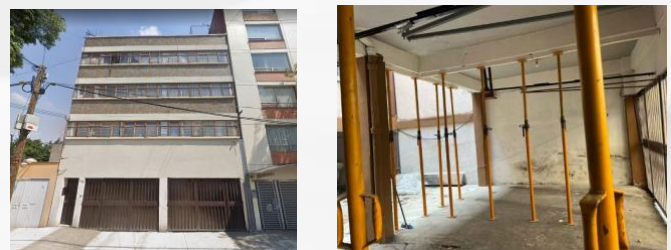
Figura 8. Edificio ubicado en Filipinas No. 178, Benito Juárez.
