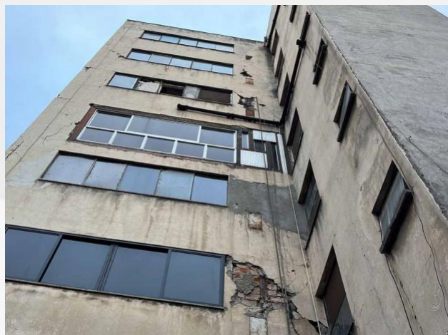
Figura 10. Daños en el edificio ubicado en Dr. Lucio No. 126, Cuauhtémoc; obsérvese la modificación estructural de un ventanal que aumenta enormemente la vulnerabilidad ante sismos.
