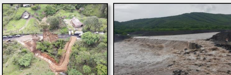
Daños en el sector carretero (Jalisco)
