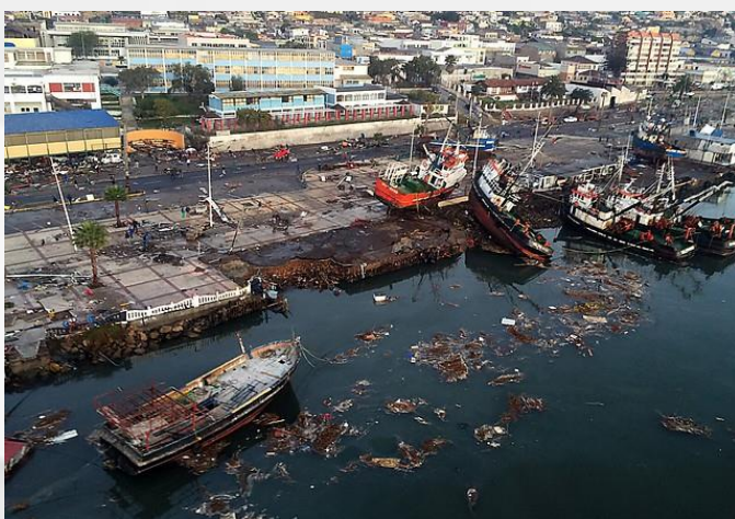
Figura 6. Daños en el Puerto de Coquimbo. Fuente: Noticias t13
