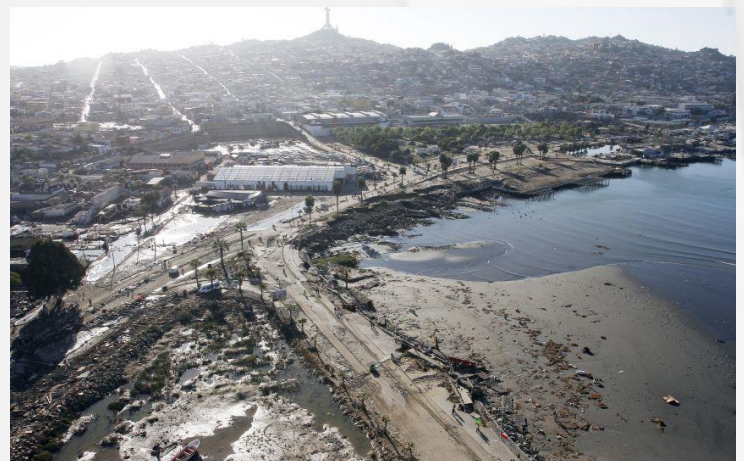
Figura 6. (Continuación). Daños en el Puerto de Coquimbo. Fuente: Usuario de Flickr (Carlos Ruiz) (arriba) y Agencia Uno (abajo)
