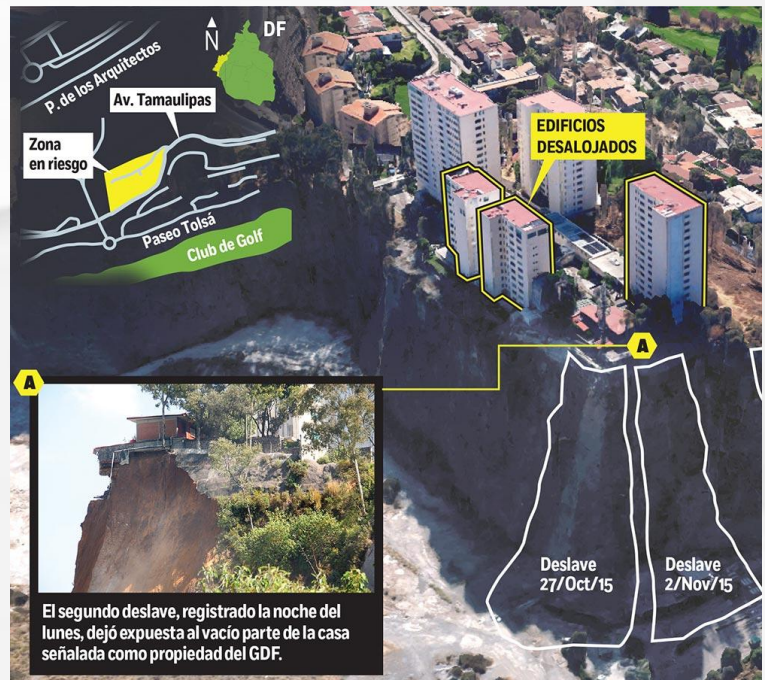
Figura 1. Zonas afectadas por los deslizamientos en Santa Fe.
