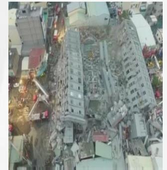
**Edificio Weiguan:** 16 pisos y un sótano, con capacidad para 256 residentes distribuidos en 96 departamentos, construido en 1995. Nótese el cambio de muros y columnas no solo entre la planta baja y el primer piso, sino entre los pisos 2-5 y el resto de los pisos superiores. La planta baja, además de tener menos elementos resistentes, es de doble altura, lo que aumenta enormemente su vulnerabilidad ante terremotos
