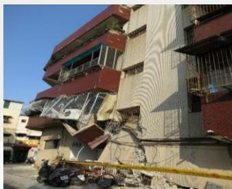
**Tachi Market:** 4 pisos construido en 1984. Al igual que los anteriores, la planta baja, más débil que los pisos superiores por la ausencia de muros, no es capaz de resistir las fuerzas sísmicas provocando el colapso y pérdida total del edificio.
