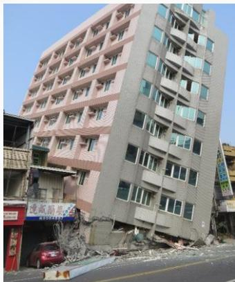
**King's Town Bank:** 11 pisos y un sótano, construido en 1996. Nótese el cambio de muros y columnas entre la planta baja y el resto de los pisos superiores. La planta baja, al tener menos elementos resistentes, es muy débil y frágil, lo que causó el colapso y pérdida total del edificio
