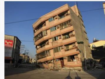
**Xinfu building:** 7 pisos con sótano. Al igual que los anteriores, la planta baja, más débil que los pisos superiores por la ausencia de muros, no es capaz de resistir las fuerzas sísmicas provocando el colapso y pérdida total del edificio.
