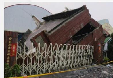
**Old office building:** 4 pisos, construido en 1975. Aparentemente más regular que los anteriores, este edificio tiene en una de sus fachadas ventanas en la planta baja mucho mayores que el resto de los pisos, lo que le quita resistencia justo donde más se necesita, ocasionando el colapso y pérdida total del edificio.
