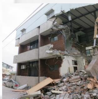
**Street Building:** 4 pisos, construido en 1979. Nótese que la planta baja colapsó totalmente (ver coche aplastado) debido a que en ella había menos columnas. Esto es una práctica generalizada en todo el mundo, y es para contar en la planta baja con más espacios para comercios y estacionamiento, pero a cambio de disminuir enormemente la resistencia sísmica donde más se necesita.
