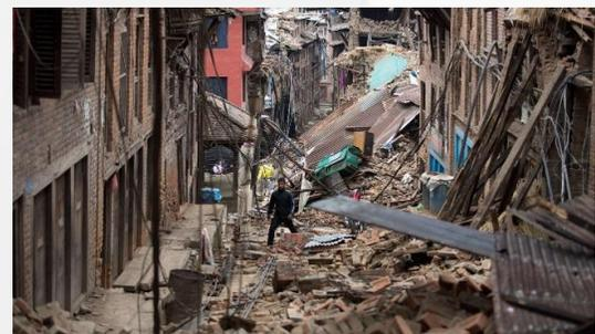
Figura 3. Daños en viviendas con sistemas estructurales muy vulnerables a sismos. Fuente: Latines.com
