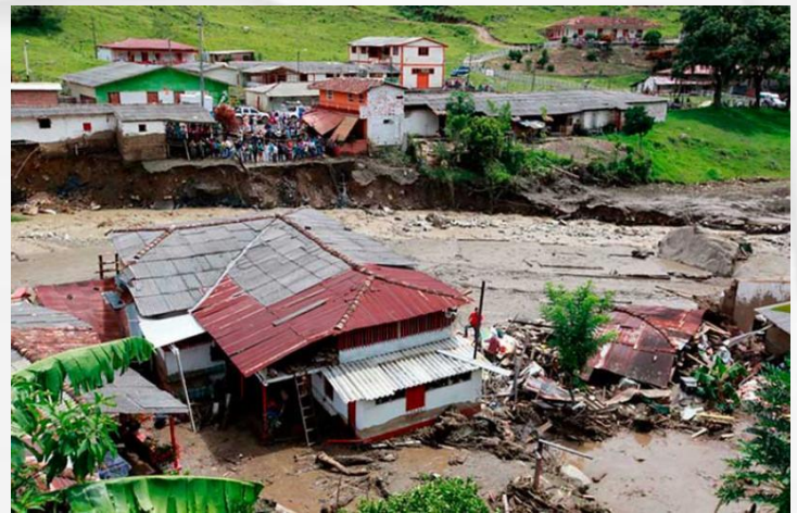
Figura 2. Daños ocasionados por la avenida torrencial. Fuente: Noticias Caracol
