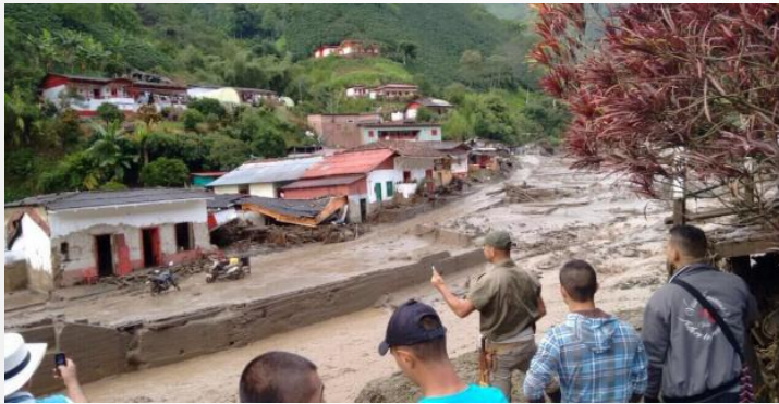
Figura 4. Daños en vías inmediatas. Fuente: El Colombiano
