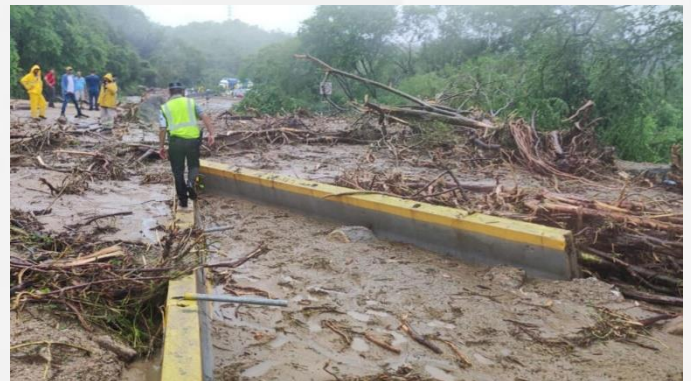
Figura 2 Deslave de terreno en el Km 360 de la autopista del Sol
