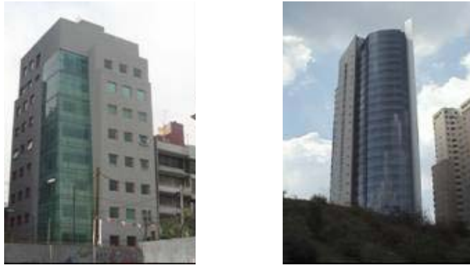
(b) Edificaciones tipo edificio (vivienda, izquierda, y oficinas, derecha)
