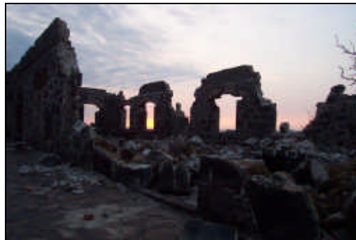
Figura 5 La construcción histórica del siglo XVII, "La Contaduría", perdió el 50% de sus muros de mampostería, que no resistieron el embate de los fuertes vientos. (Foto: ERN)
