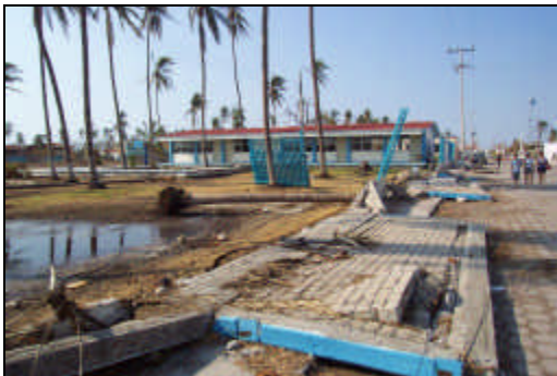
Figura 4 La barda perimetral del Centro de Estudios Tecnológicos del Mar se colapsó en 90% de su extensión. La caída de muros fue extensiva en todo el poblado. (Foto: ERN)
